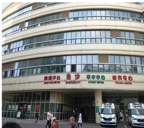
项目北侧1号楼
